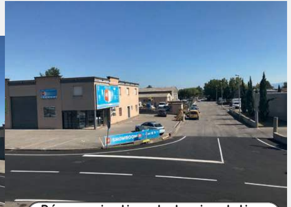
Réorganisation de la circulation par la création de nouveaux marquages au sol.
