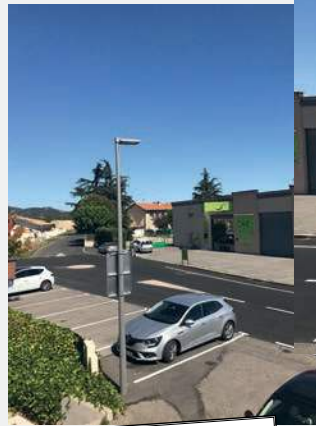
Renforcement de la voirie endommagée
