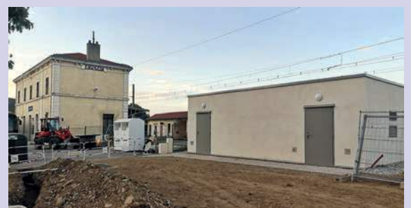
Construction de deux locaux NRO (nœud de raccordement optique) préalables au déploiement de la fibre.
